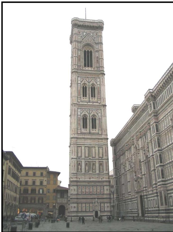
**Analisi Dinamica:** misura delle vibrazioni della torre quando suonano le campane.
